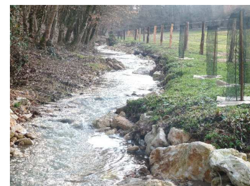
Après travaux de renaturation, plantation et clôture : resserrement du lit, décolmatage du lit, habitats diversifiés, vitesse et lame d'eau plus importante
