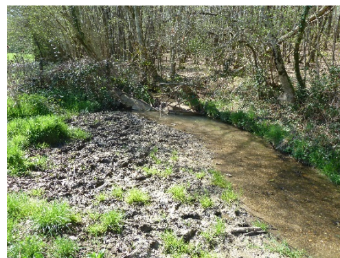
Avant travaux : effondrement des berges, élargissement et colmatage du lit, faible lame d'eau
