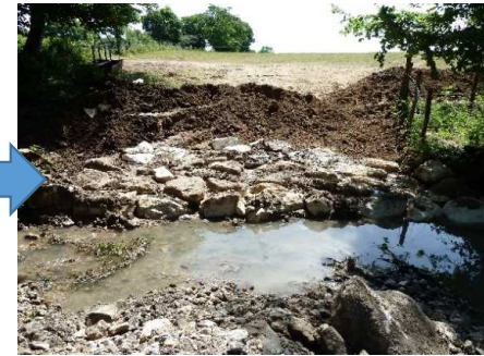
Empierrement des berges
