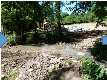
Décaissement des 2 berges
