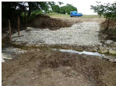
Calage des blocs par de la granulométrie plus petite
