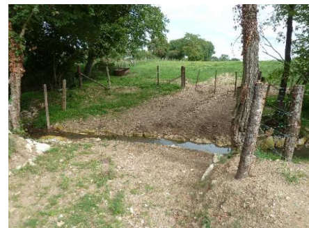
Recouvrement de terre, ensemencement et clôture
