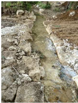
Canalisation du débit d'étiage à travers un cordon de blocs
